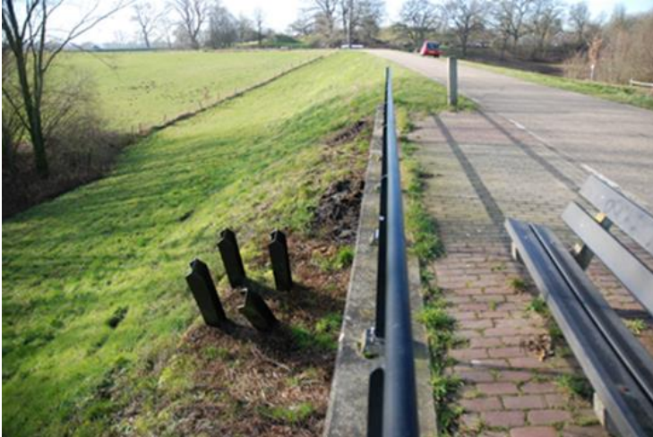
Afbeelding 29 Zichtbare restanten van de tankversperring in het buitentalud. Bron: Graaf Reinald Alliantie.
