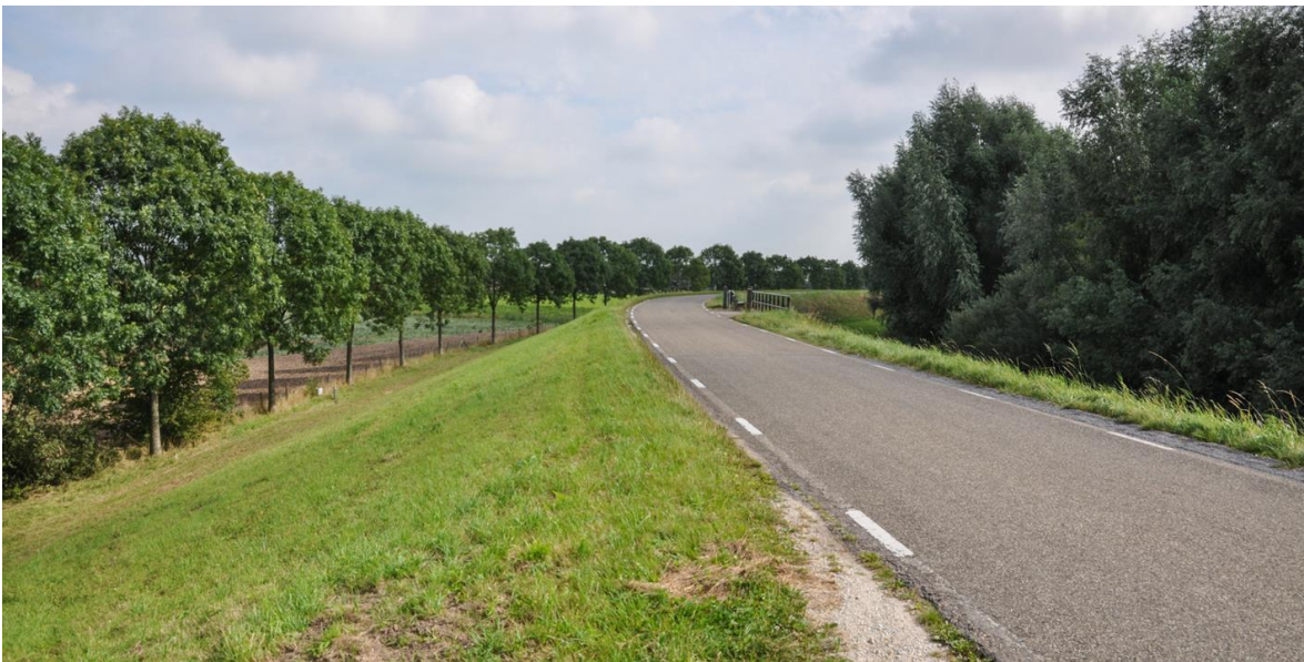
Afbeelding 30 De dijk aan de oostzijde van het Fort bij Vuren; net achter de jonge bomenrij bevond zich de Herwijnsche Wetering in het inundatieveld. Bron: Graaf Reinald Alliantie.
